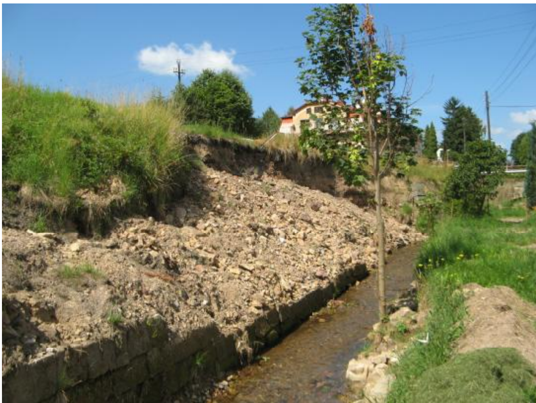
obr. 3 Celkový pohled na sesuv silničního náspu
