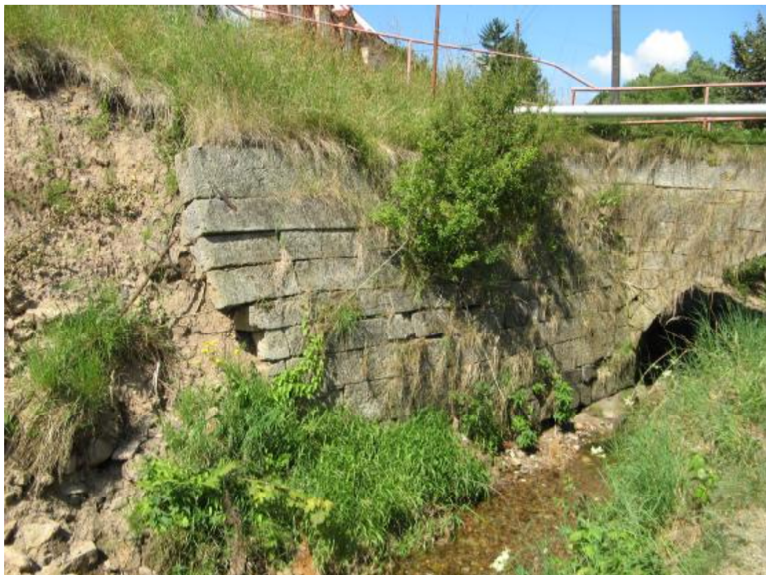
obr. 1 Porušení opěrné zdi při výtoku z mostu
