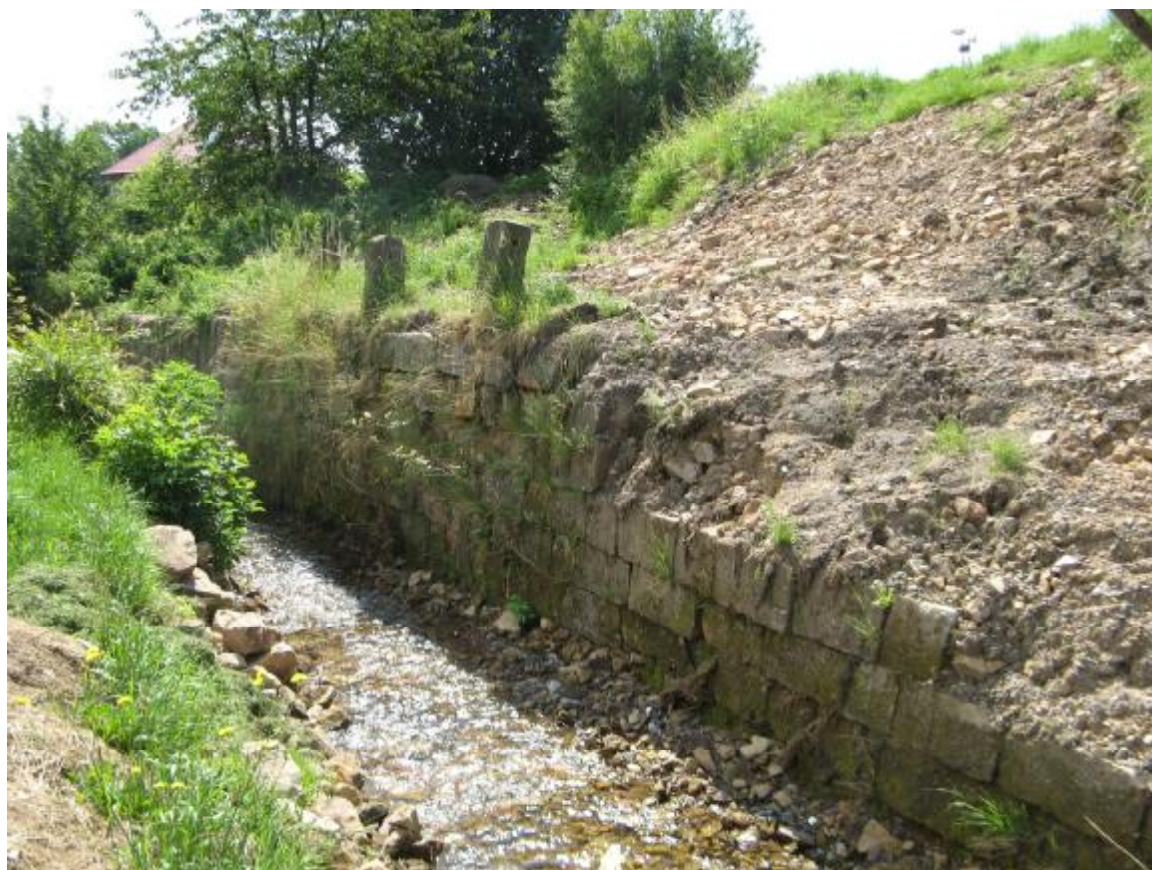
obr. 5 Porušení opěrné zdi v zakončení úprav
