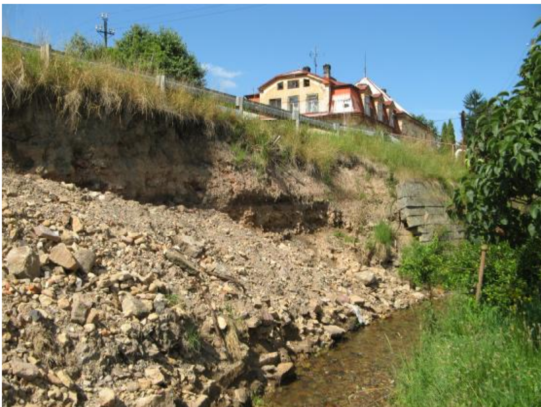
obr.2 Sesuv silničního náspu
